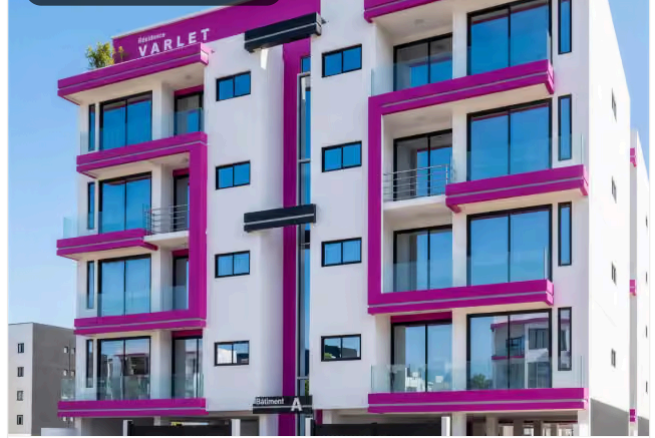
Façade principale sur rue
